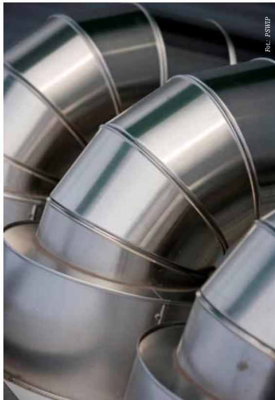
Fot. 1 Widok izolacji rurociągów i aparatów.
